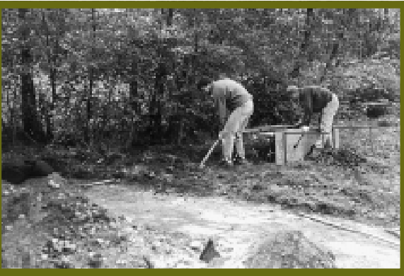
Freilegung der Hauptlagerstraße
