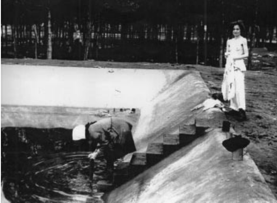
Wasserbecken zur Zeit der Befreiung (1945)
